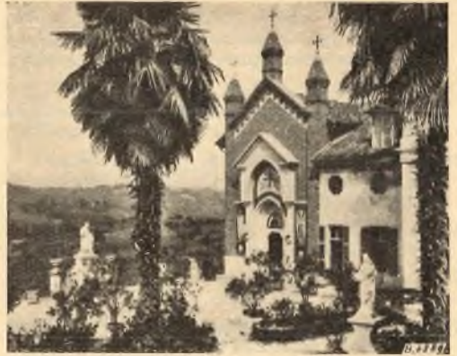
Castelnuovo Don Bosco. -- Ingresso alla Cappella
